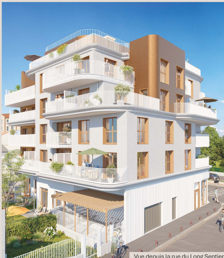
Vue depuis la rue du Long Sentier.
